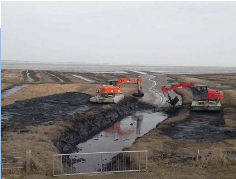
Räumung Hauptentwässerung (Amrum 2018)
